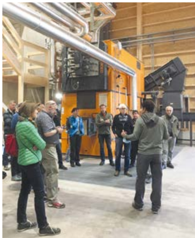
Bürgerratsmitglieder vor dem imposanten Heizkessel.
