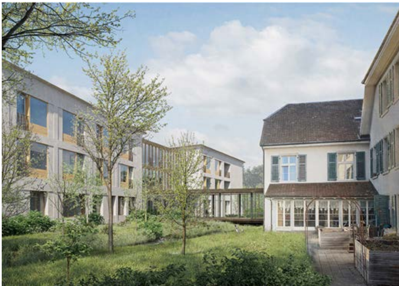
Der Zwischenbau – Verbindung zwischen alt (rechts) und neu (links).
