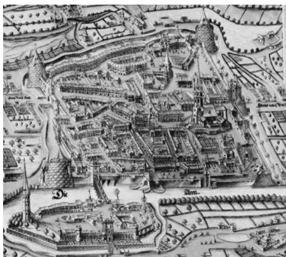
Riedholzturm oben rechts
